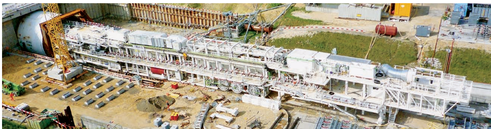
Zurück zum Start. Belena wird für die nächsten beiden Tunnelröhren im Bözingenfeld in Position gebracht.
