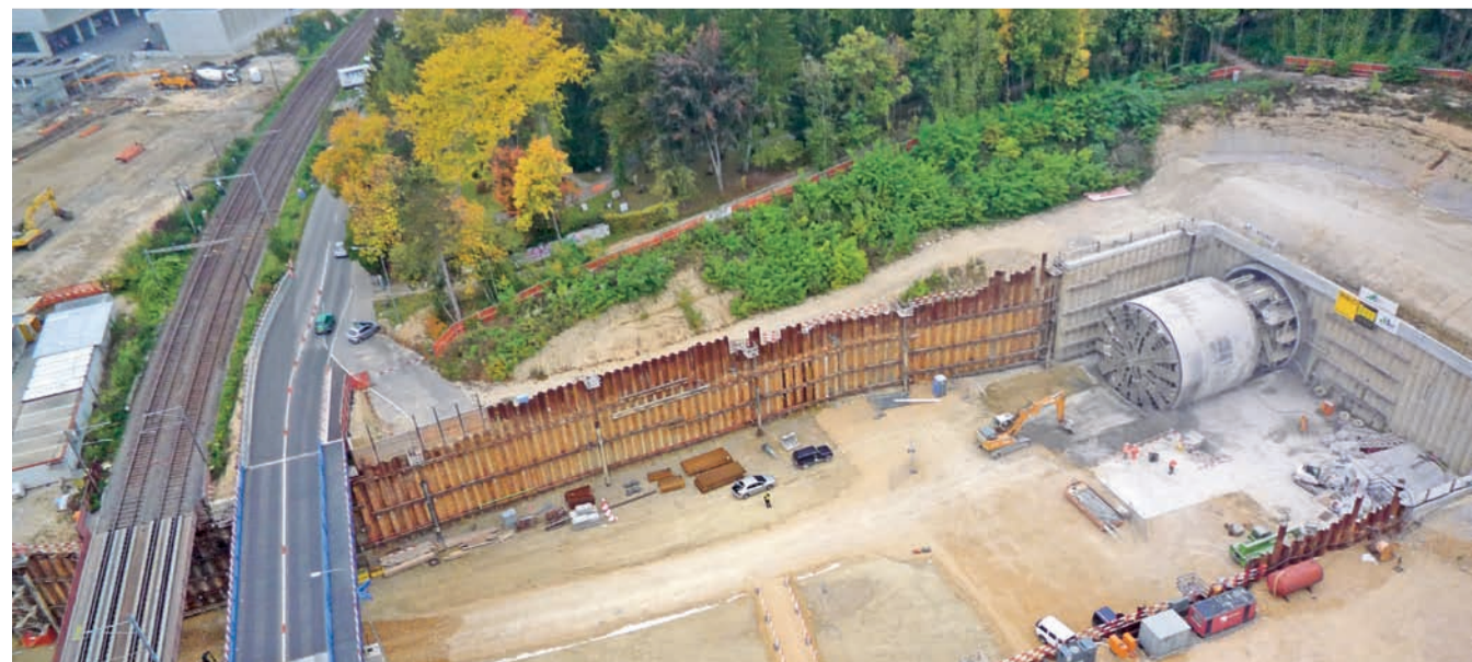
Seltener Anblick: Der imposante Tunnelbohrkopf von Belena nach dem Durchstich in Brügg. Image historique: La tête d'abattage transperce les derniers mètres à Brügg.
