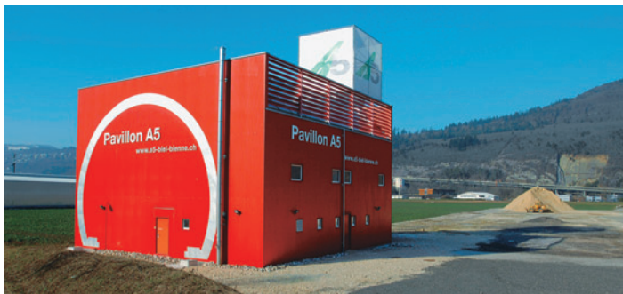
Der A5-Pavillon im Bözingenfeld ist von weit her sichtbar. (Bild Guy Perrenoud)
